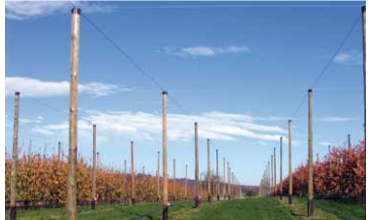
Die Stangen werden bei allen Gerüstarten gleichermaßen im Abstand von 8,00 m – 10,00 m aufgestellt
